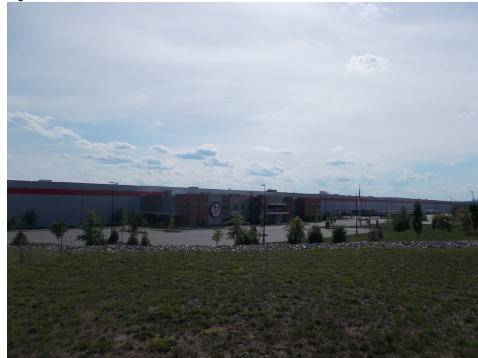
F. W. Webb distribution center
